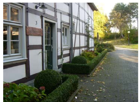
Eingang Fachwerkhaus Stockebrand
