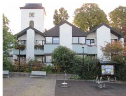
Ostseite mit Wohnbebauung
