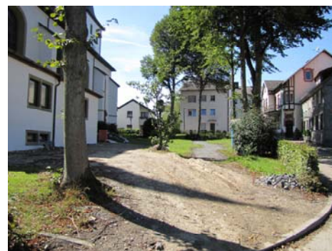
Spuren der Bauarbeiten im Umfeld
