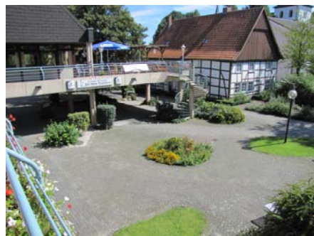
Haus des Gastes mit Übergangsbereich zum St. Elisabeth Alten- und Pflegeheim + Schule
