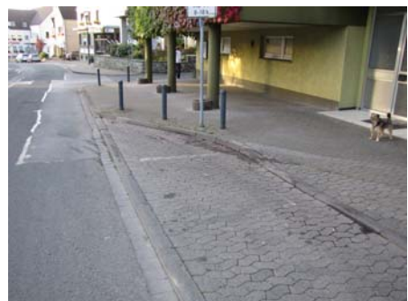
Graues Verbundsteinpflaster und Asphaltdecke im Ortszentrum
